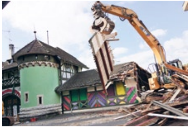
Die Bagger machen aus dem ehemaligen Schiessstand Kleinholz. HUF
